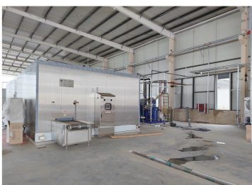
辅助设备安装
