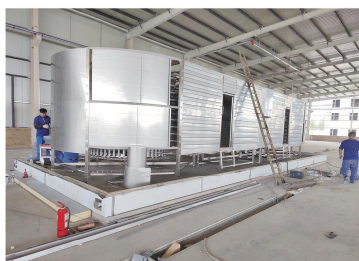
前期设备安装
